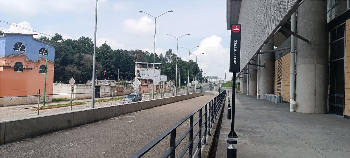
Fotografía 1. Estación de Zinacantepec vista desde la salida peatonal de la estación
