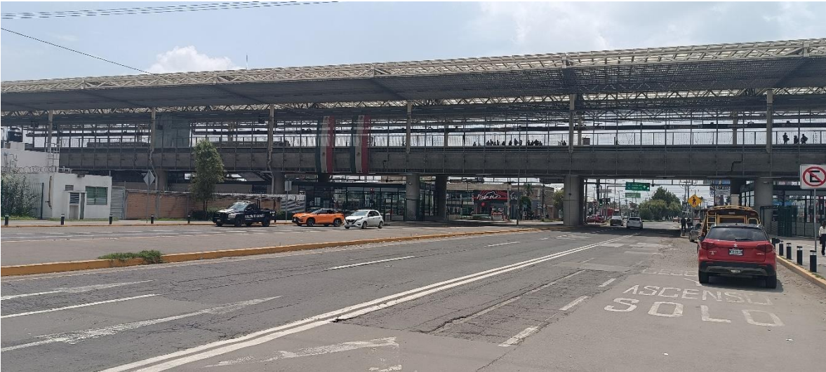
Fotografía 9. Estación Metepec vista desde la avenida Tecnológico en dirección sur
