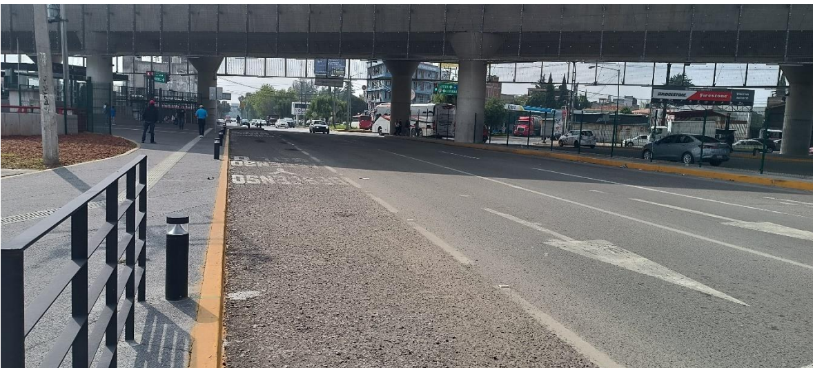
Fotografía 6. Estación Toluca Centro vista desde el boulevard José María Pino Suárez en dirección a Metepec
