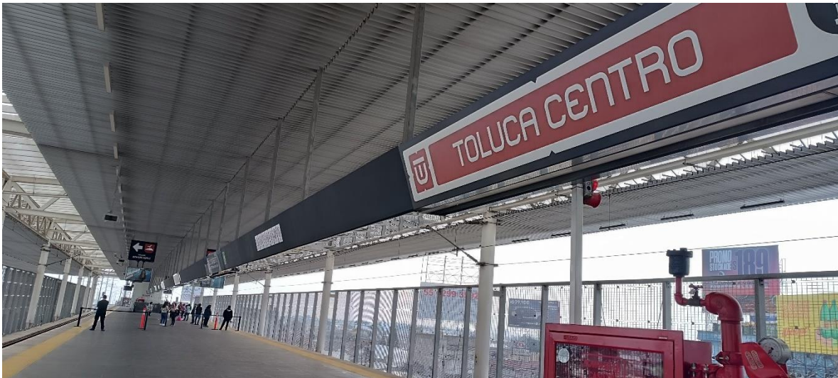
Fotografía 7. Estación Toluca Centro, vista desde el andén
